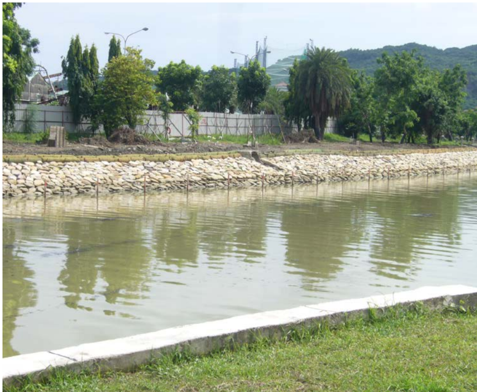
照片六 學校旁後勁溪護堤水土保持生態工程法(拍攝者:黃佳雯，2013)
